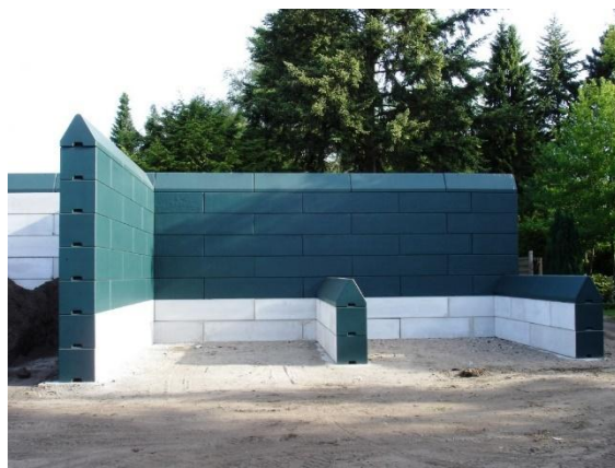
Area stoccaggio - parete protezione antincendio, foto: MEGABLOC
